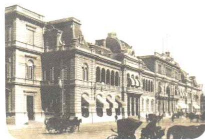
Vista frontal de la Casa Rosada con los dos edificios unificados, a fines del siglo XIX.
